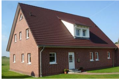
Neues Einfamilienhaus in ruhiger Lage (Strandnähe: 100 m)
